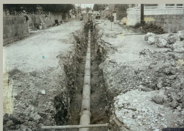
北谷町下水道事業砂辺・浜川地区の第1期工事。未舗装道路を露天掘りして下水道管を敷設している様子が見える。現在は用途廃止して無くなった砂辺ポンプ場も建設された。
