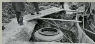
北谷町下水道事業謝対地区の第2期工事。旧役場（現在の北玉児童館）付近の下水道工事。北玉小学校前の坂道は現在も面影を残しており、当時設置されたマンホールの一部が現在も残っている。
