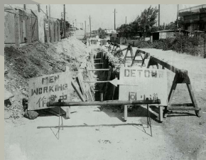
北谷町下水道事業砂辺・浜川地区の第1期工事。未舗装道路を露天掘りして下水道管を敷設している様子が見える。現在は用途廃止して無くなった砂辺ポンプ場も建設された。
