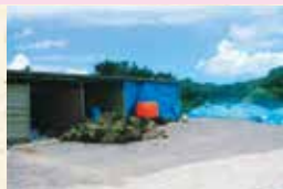
草木類資源化処理施設
