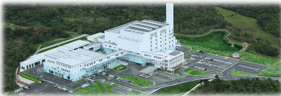
エコトピア池原（熱回収施設）・エコループ池原（リサイクルセンター）
