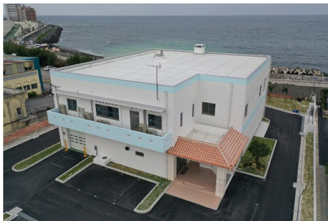
汚泥再生処理センター「宜野湾清水苑」
