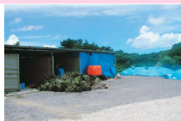
草木類資源化処理施設
