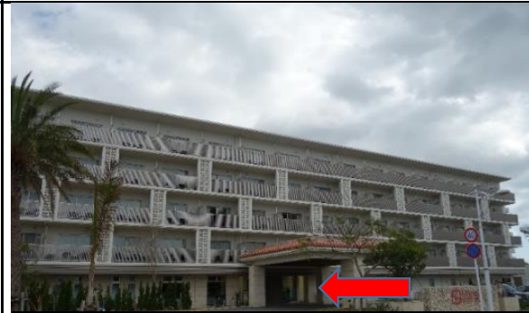
正面入口に入り、フロント左側の階段から避難
