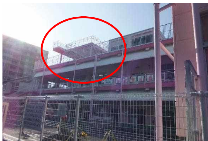
図 15 屋上への避難場所を増築した事例
