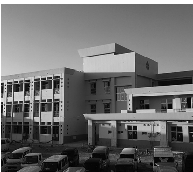
▲改築中の北谷第二小学校
