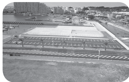
▲係留施設（陸上）
