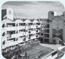
▲町営栄口住宅
