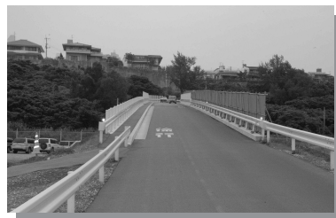
▲土木費：桑江17号線新設事業 156,200千円、町の東部と町役場を結ぶ道路の完成により、役場への利便性の向上を図った。
