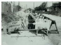
1971年 第1期砂辺地内 公共下水道工事の様子
