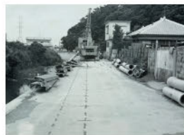
1972年 第2期謝対地区 公共下水道工事の様子
