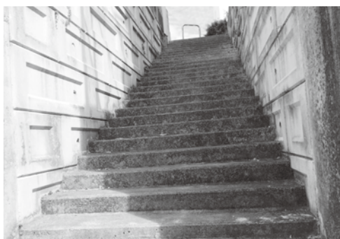
手すり設置予定の避難道
