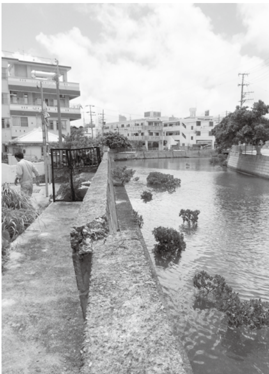
早目の改修が待たれる護岸
