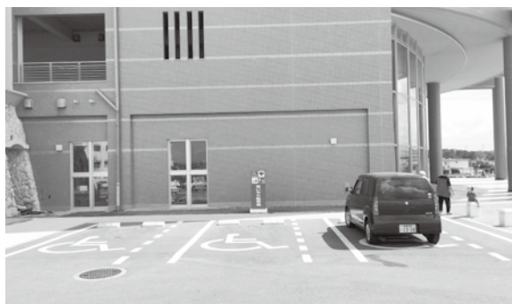
屋根の再設置が待たれる駐車場
