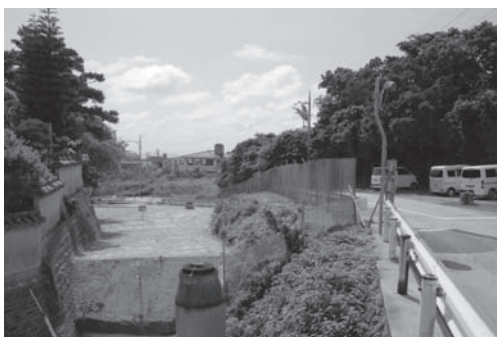
改修中の17号線
