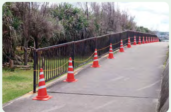
修繕が必要な港海岸の防除柵
