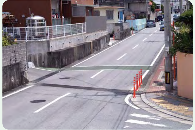
交通事故対策が望まれる砂辺浜川線
