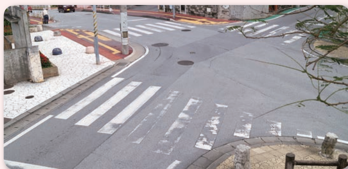
消えかかった北谷小学校前の横断歩道
