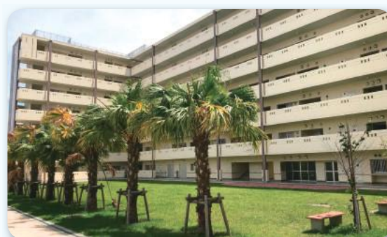
防犯対策がのぞまれる公営住宅
