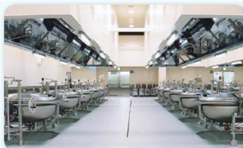
設備が整った給食センターを早く！
