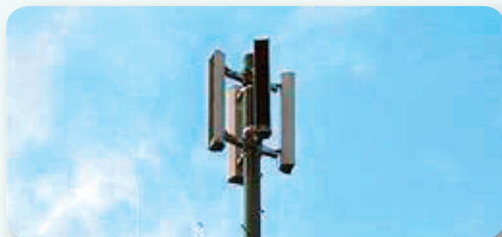
新しく設置する屋外スピーカー
