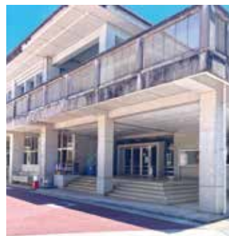
各体育館の空調整備で災害時の熱中症対策！
