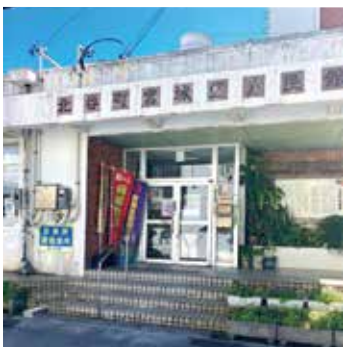
公民館の老朽化の状況と維持・更新は、どうなっているのか
