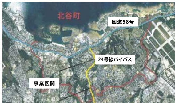
県道24号線バイパスの早期整備を望む (沖縄県ホームページより)
