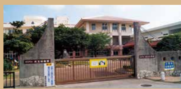
北玉小学校及び幼稚園屋根瓦改修事業 小学校 5,933万7千円 幼稚園 1,302万5千円 合計 7,236万3千円
