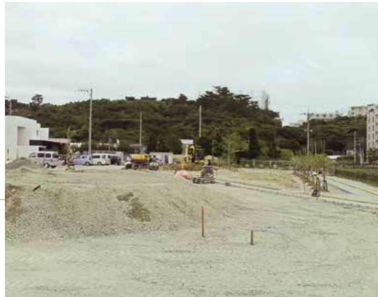
屋根設置の再検討を望む。桑江伊平地区5号街区公園!
