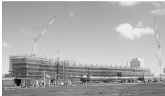
着々と進むヒルトンホテル
