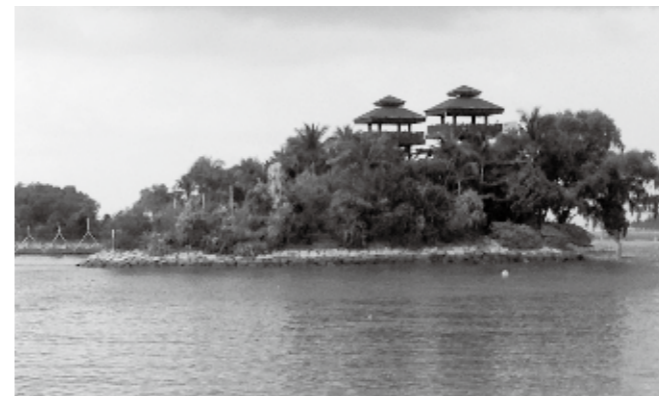
工夫された沖の防波堤 (シンガポール)
