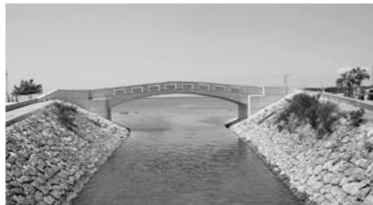
4月13日に開通した塩川橋
