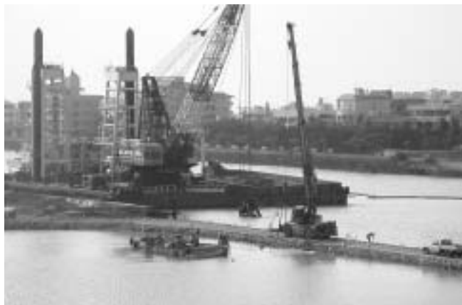
泊地しゅんせつと埋立工事
