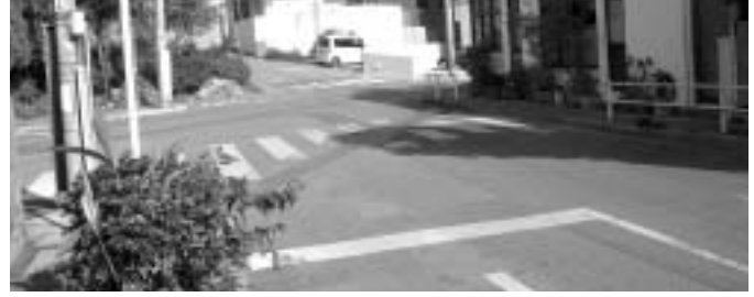
早急な改良工事がまたれる浜川小北側交差点
