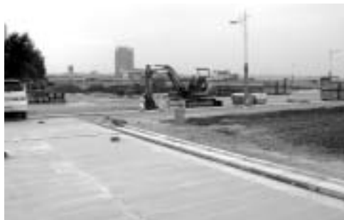
埋立造成工事が完了したフィッシャリーナ
