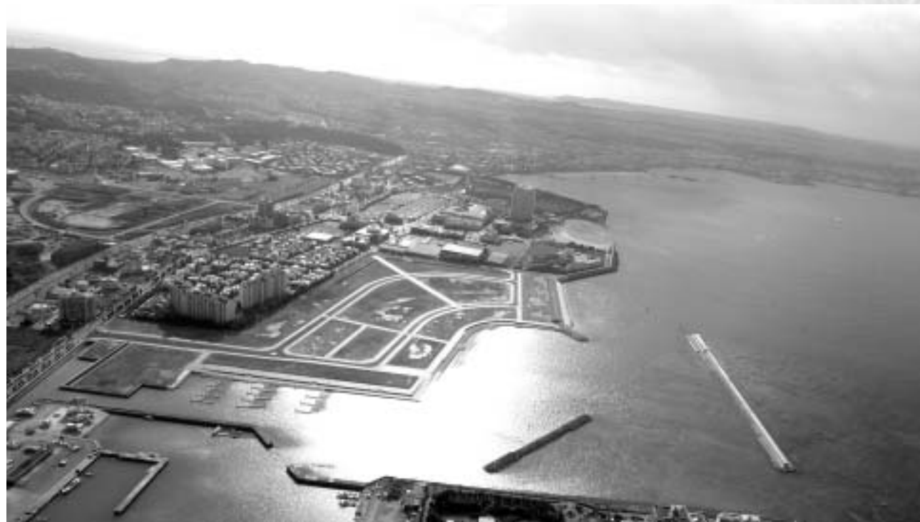
フィッシャリーナ竣工後の全景写真 (浮き桟橋、道路、街灯、電線類の地中化が完了)
