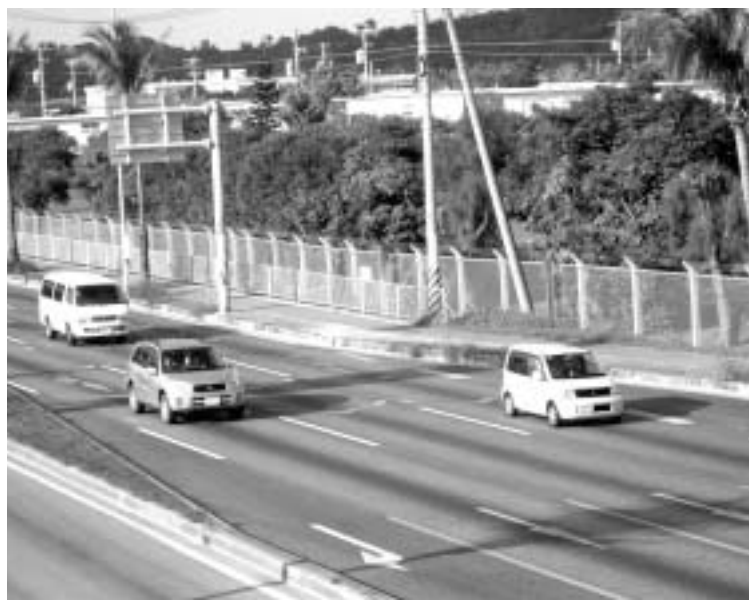
国道58号は拡幅予定
