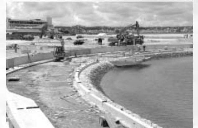
護岸及びプロムナード造成工事
