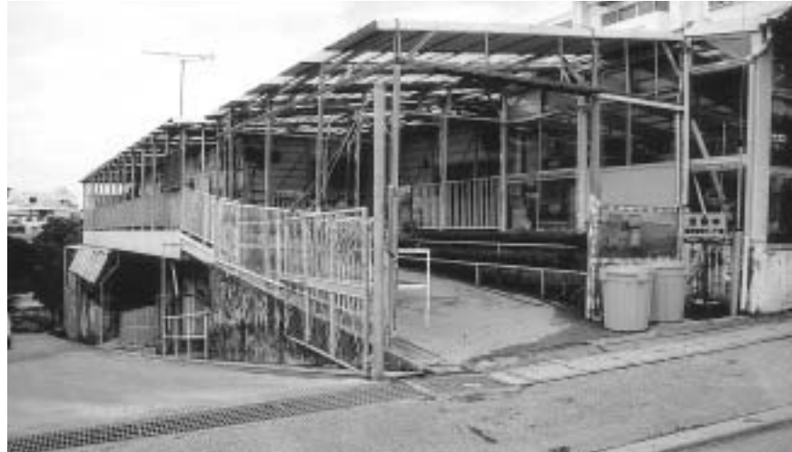
「青空」「にライの里」舎屋
