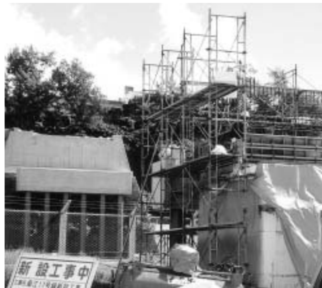
桑江17号線の工事は急ピッチ
