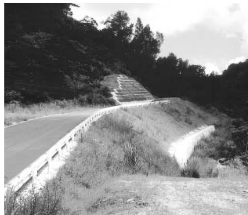
新川線の延長工事が近く着工されます。
