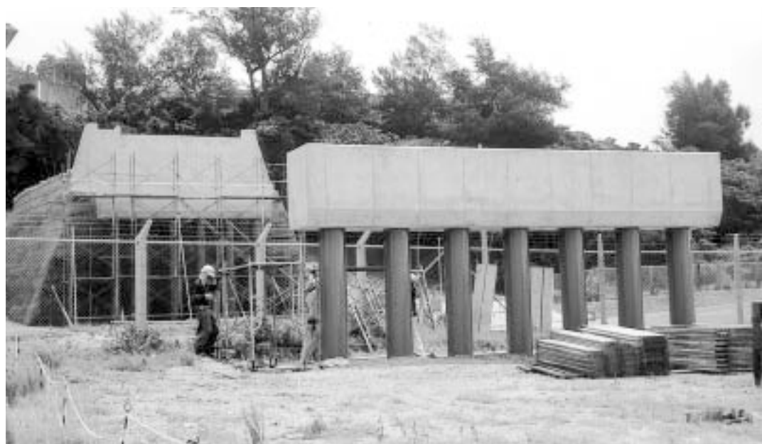
桑江17号線の橋りょうが完成間近
