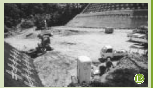
北玉4号線改良舗装事業 ■17年度事業費 1億4076万8千円 (切土、法面工及び路盤工)
