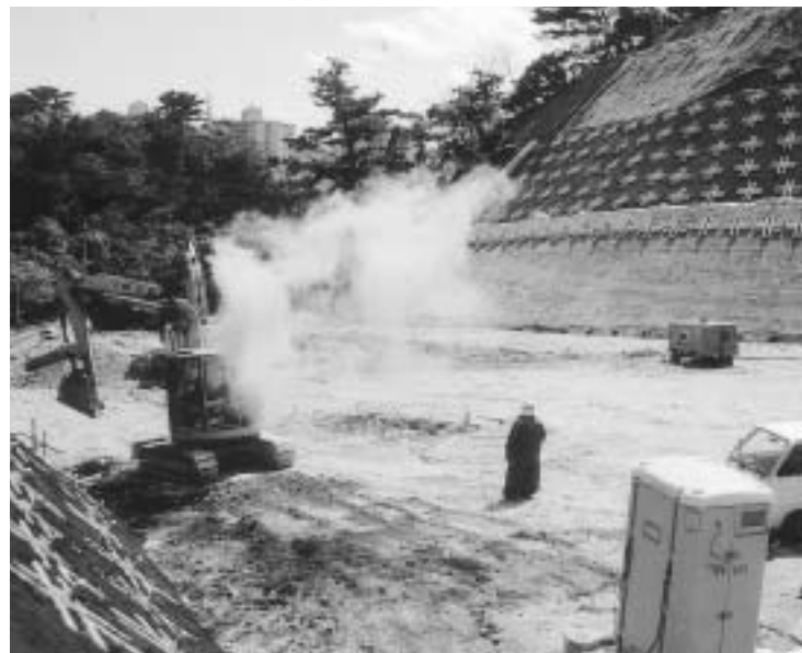
北玉4号線工事現場
