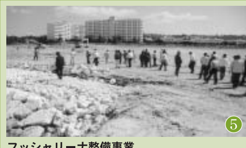
フッシャリーナ整備事業 ■浜川漁港多目的利用施設整備事業(西護岸、防波堤) 請負金額 3億6015万円 ■浜川漁港多目的利用施設整備事業(係船護岸・浚渫・埋立) 請負金額 7億6051万5千円
