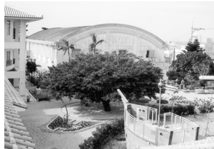
全面改築が決定した北玉小体育館
