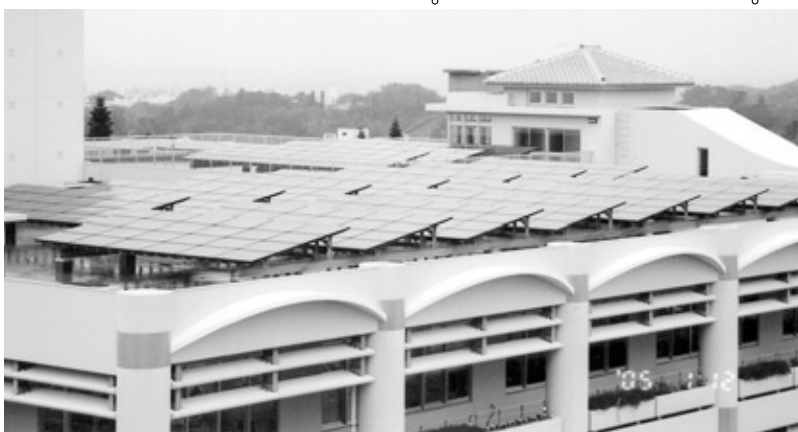
ちたんニライセンターの屋上には太陽光発電施設を設置
