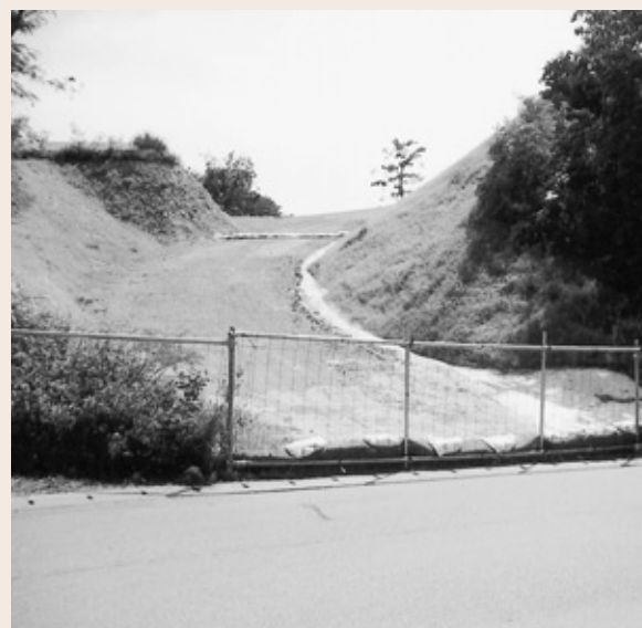
工事途中の北玉4号線改良工事
