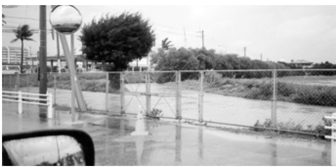
大雨のたびに冠水する庁舎前の排水路(6月11日)
