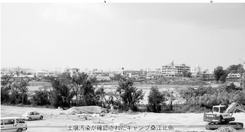
土壤汚染が確認されたキャンプ桑江北側
