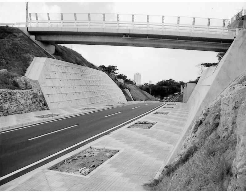
開通した玉上・宇地原線：ナボリ線陸橋との立体交差点付近
