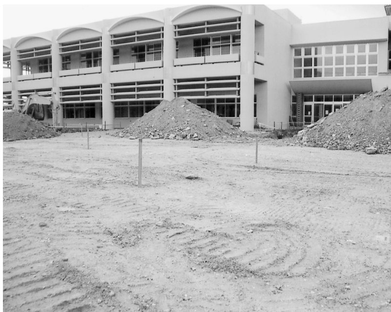
外構工事建設中の北谷ニライセンター
