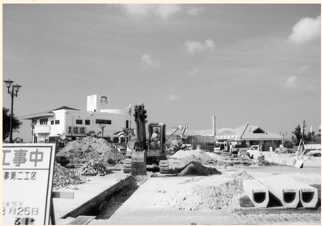
温泉施設は急ピッチで工事中
