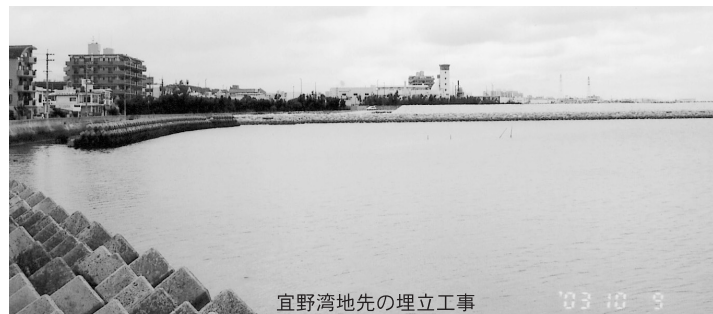
宜野湾地先の埋立工事
