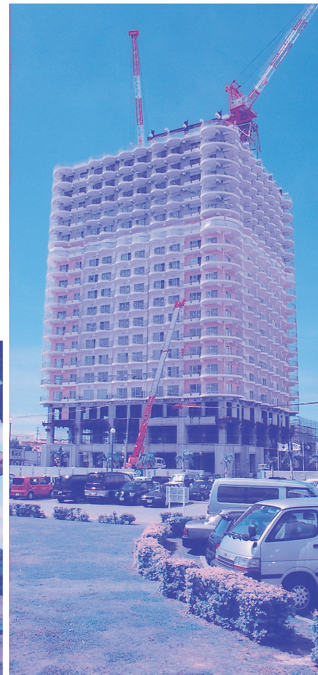
建設中の長期滞在型ホテル
