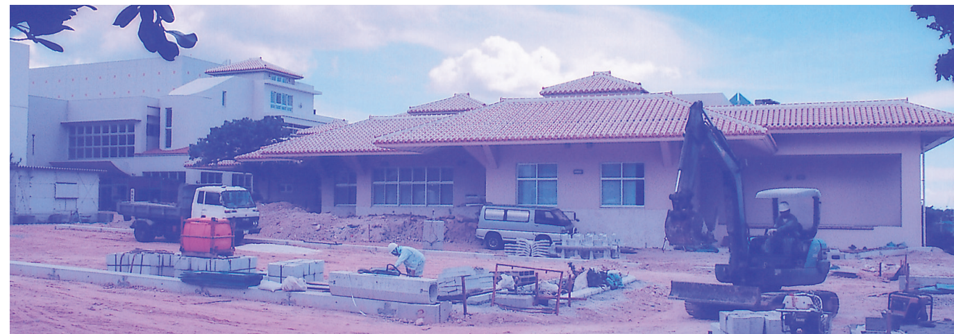
駐車場整備中の生涯学習支援センター
