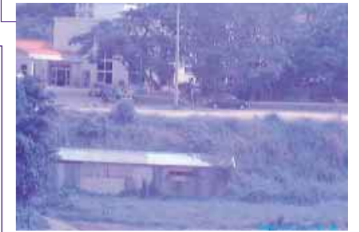
社協事務所・保育所・子育て支援センター建設地
