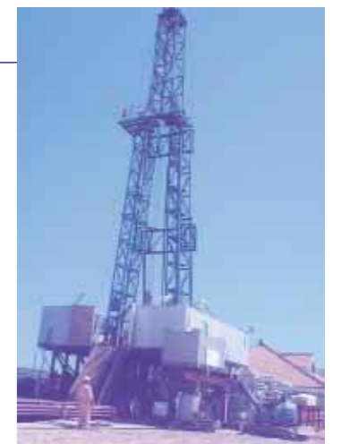
温泉利用施設掘削現場
