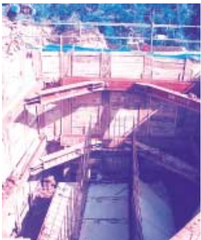
高架橋の基礎工事中のナポリ線
