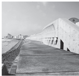
宮城海岸の護岸は津波に耐えられるか
