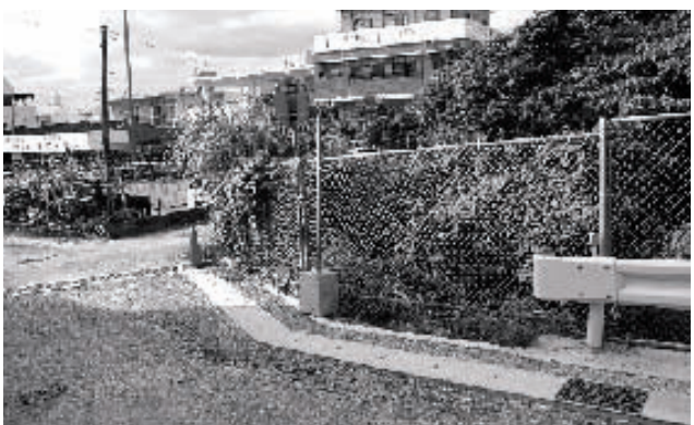
整備が待たれる受水洞周辺道路
