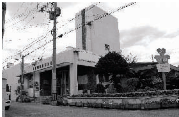
築30年が経過した宮城公民館
