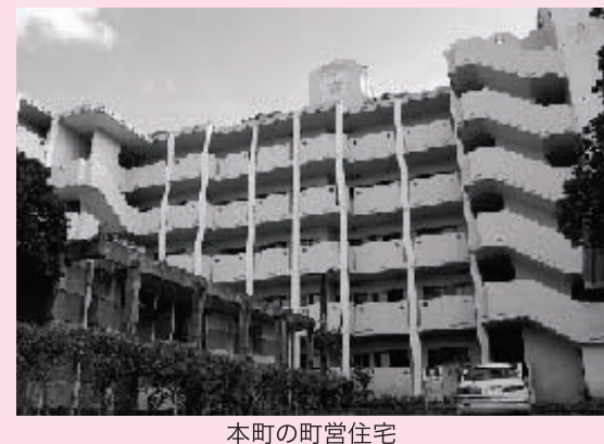
本町の町営住宅
