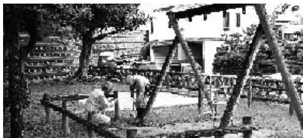
20年経過した公園の遊具点検(上勢頭南公園)
