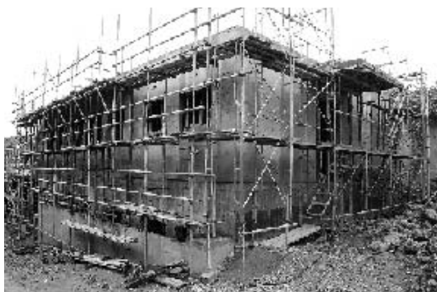
心身障害者授産施設の工事現場
