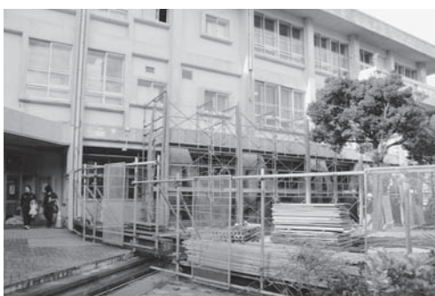
北谷中学校耐震化工事中
