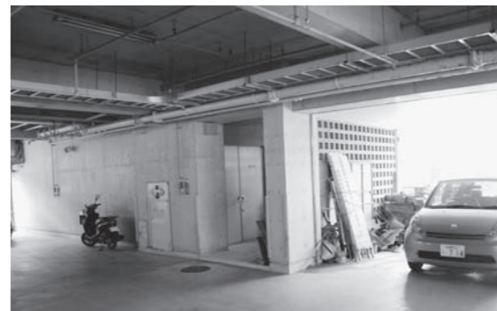
改善が問われる消防団詰所
