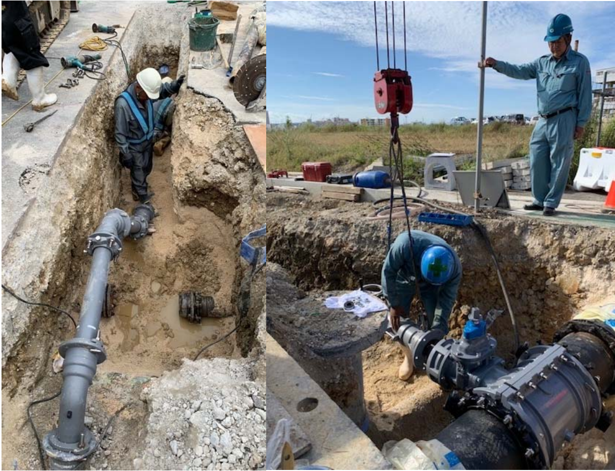
耐震管布設状況
