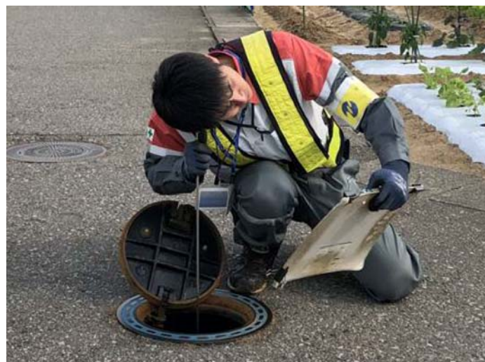
漏水調査状況
