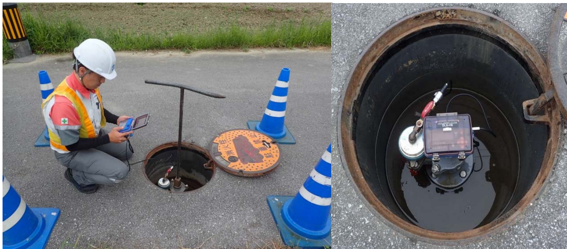
水圧測定調査状況
