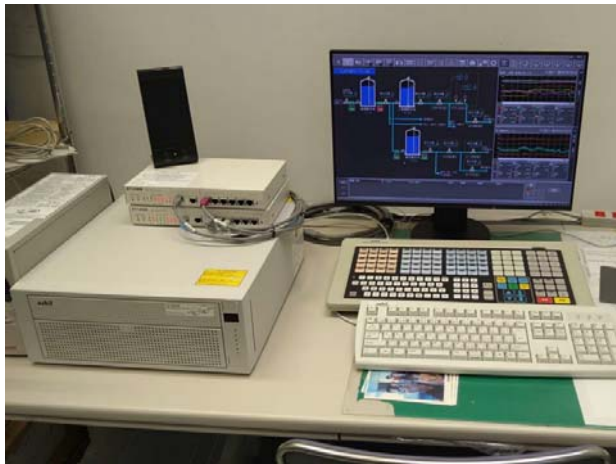
監視制御設備状況
