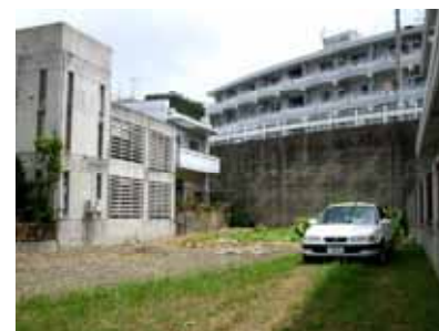
背面擁壁の住宅例（約4m）
