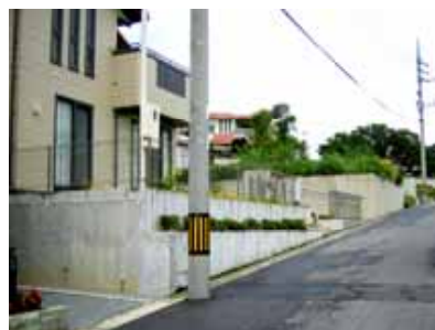
隣地擁壁の住宅例（約1.2m）
