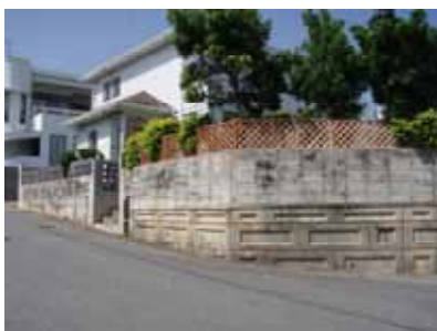
傾斜地の擁壁（緑化無し）
