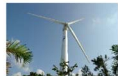
▲風力発電施設
