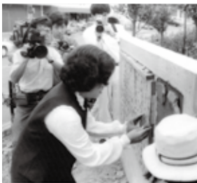
原爆瓦のはめ込みの様子(昭和2年4月)
