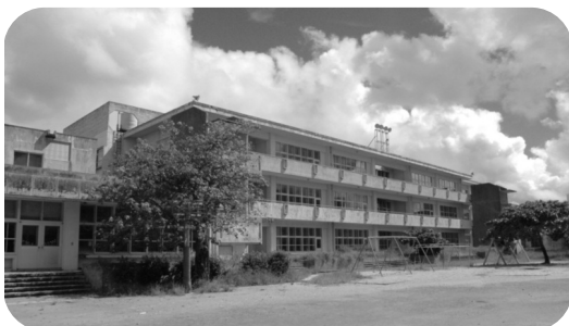
▲改築前の浜川小学校
