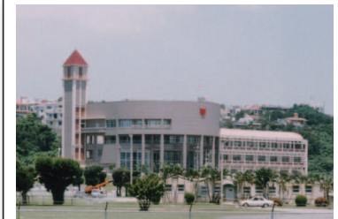
⑧ 1998(平成10)年に桑江226番地に建設された現在の北谷町役場
