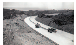
p19 県道23号(国道道路)
