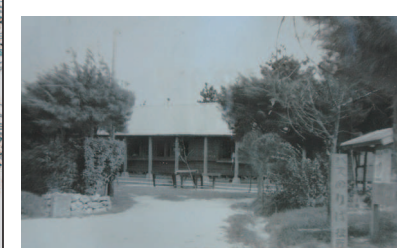
⑥ 1950(昭和25)年4月に謝苺一区に建設された木造トタン葺庁舎
