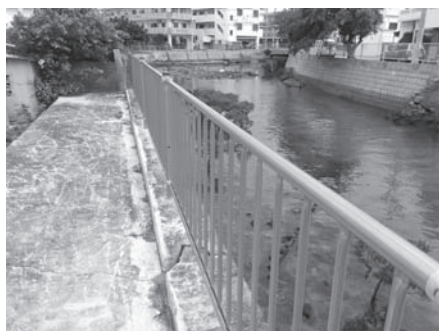
改修が済んだ護岸フェンス
