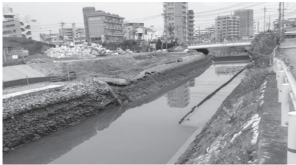
改修工事が始まる白比川
