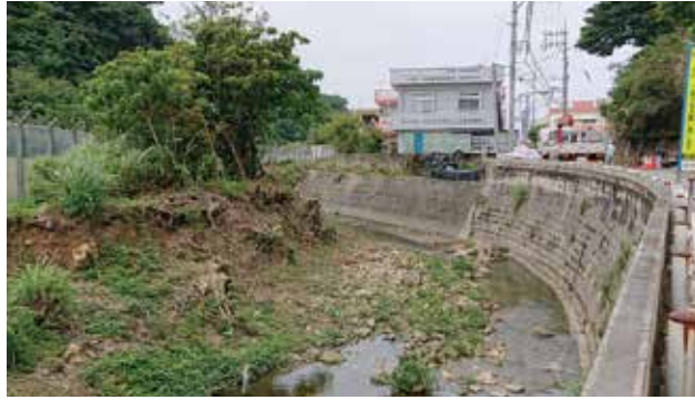
命を守る!白比川の緊急工事(高木・堆積土砂除去)
