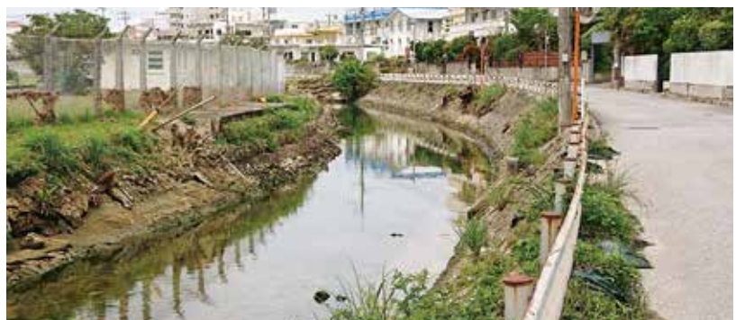
町民の安全を第一に！白比川の高木・堆積土砂除去工事！
